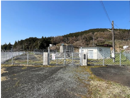
【中央簡易水道大峯配水池 全景】
