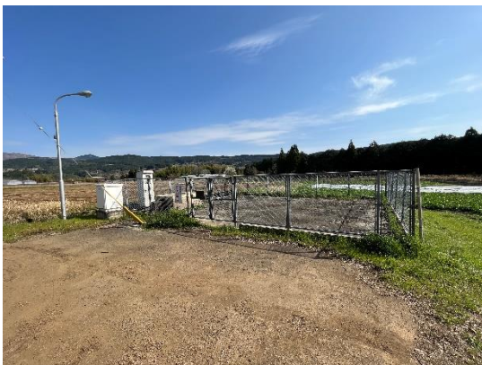
【中央簡易水道秋田原水源地 1号井 全景】
