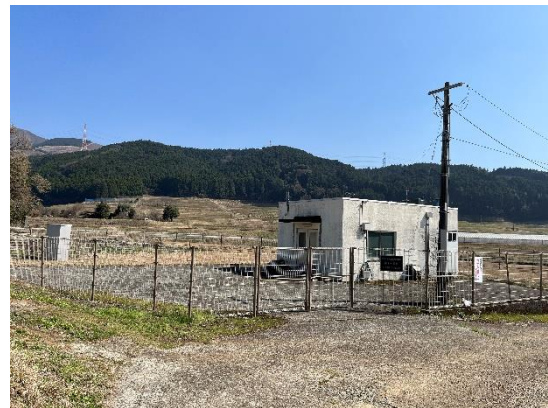
【中央簡易水道宮山水源地 全景】
