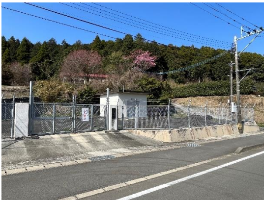
【中央簡易水道大峯水源地 全景】
