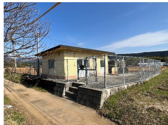
【中央簡易水道秋田原水源地 2号井 全景】
