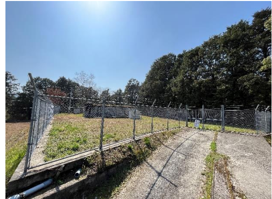
【中央簡易水道秋田原配水池 全景】
