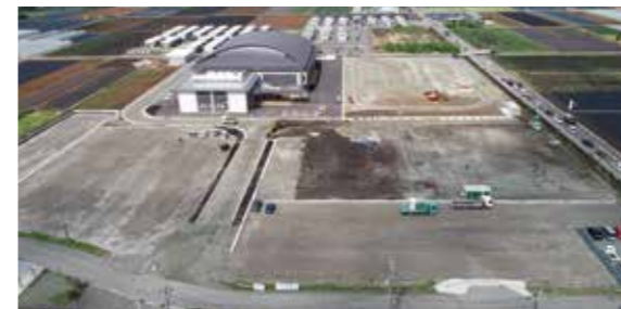
▲工事が進んでいる運動公園
