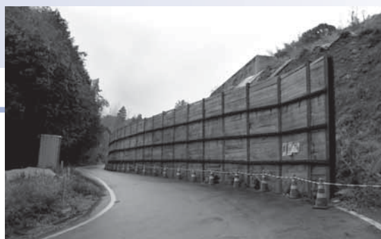
村道田中高遊線災害復旧工事
