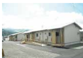
仮設住宅(木造)
