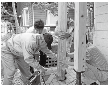
▲玄関の柱の交換と固定
