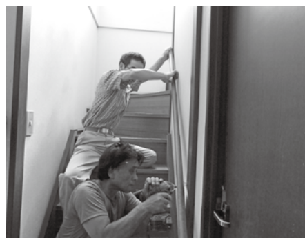
▲階段の手すり設置
