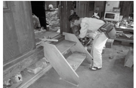
▲居間上り口階段設置
