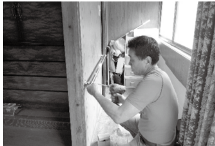
▲トイレ入口廊下の手すり設置
