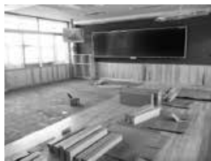
改修中の教室
