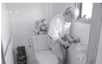
▲トイレの手すり設置
