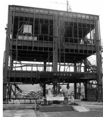
南三陸町防災センター 献花台
