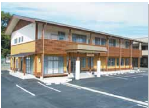
▲完成した生涯学習センター
