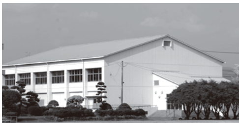
西原中学校体育館建設
