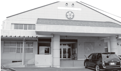
山西小学校体育館建設
