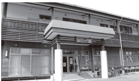
生涯学習センター山河の館建設
