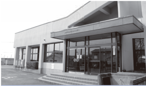
西原村構造改善センター建設
