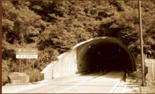
俵山トンネル開通
