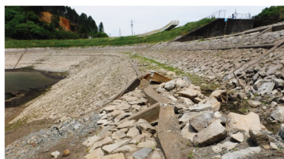
大切畑ため池における法面圧縮崩壊の様子(株式会社パスコ撮影)
