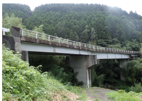
自衛隊関係車両が通過する麦の庄大橋（鋼橋） 橋長61.4m 昭和62年架設 48歳
