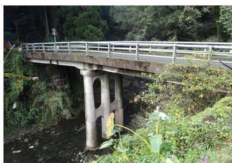
布田川を跨ぐ辰口橋（RC-T桁） 橋長20.5m 昭和30年架設 70歳
