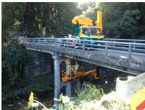
橋梁点検車による点検
