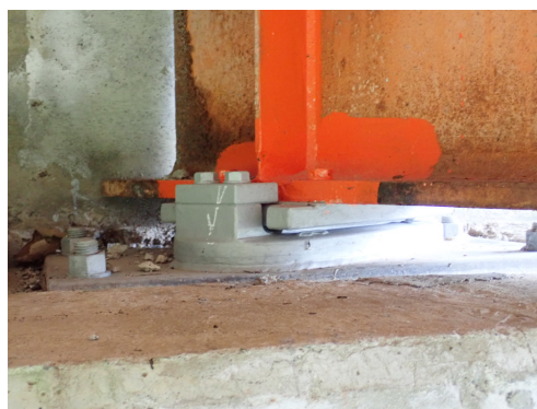
補修後（支承の交換）
