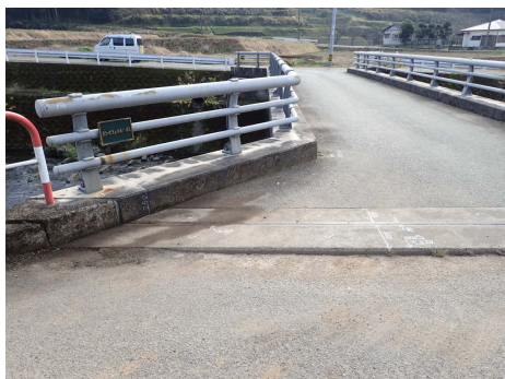
走行面の変状（路面の凹凸）
