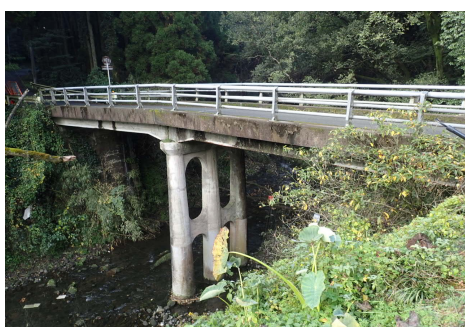
布田川を跨ぐ辰口橋 (RC-T桁) 橋長20.5m 昭和30年架設 67歳
