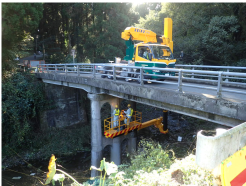
橋梁点検車による点検
