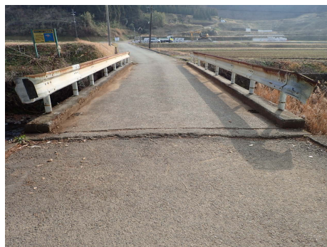
走行面の変状（路面の凹凸）
