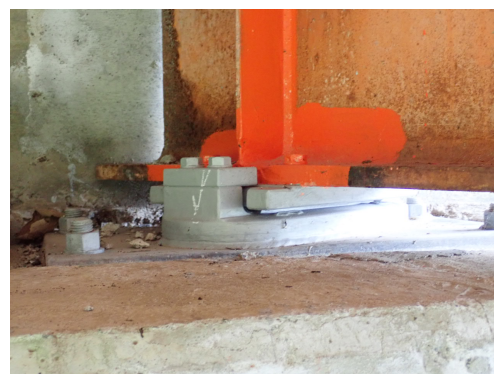
補修後（支承の交換）
