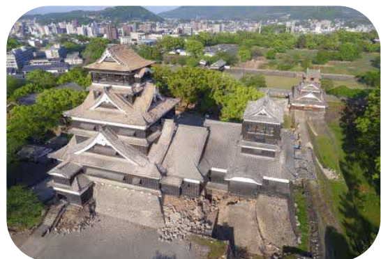
図表 4-2 熊本地震で被災した熊本城 (出典：熊本市)
