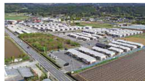
▲応急仮設住宅
