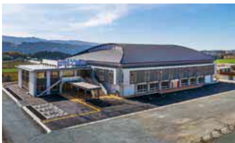
▲西原村総合体育館工事 竣工
