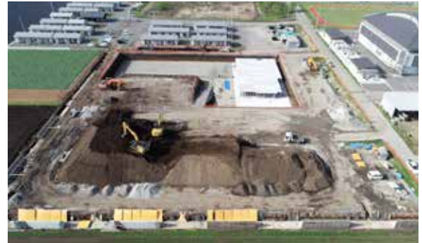
▲整備中の総合運動公園
