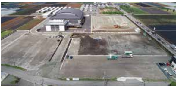
▲工事が進んでいる運動公園
