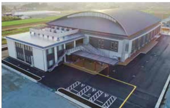
▲完成間近の総合体育館
