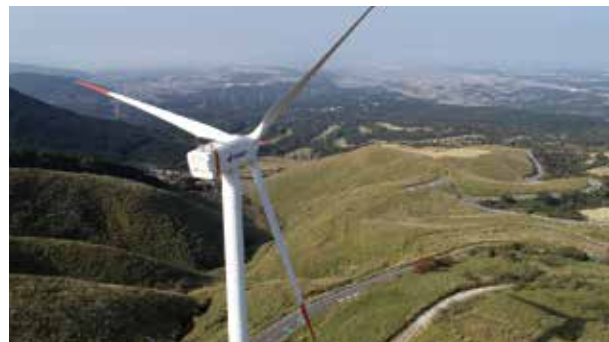
▲風が強い日や点検により回さない時は、羽根を風に対して平行にすることで回らないようにしている
