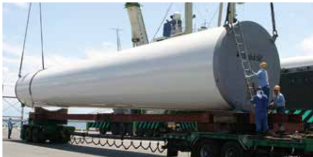
▲船から下される風車のタワー部分
