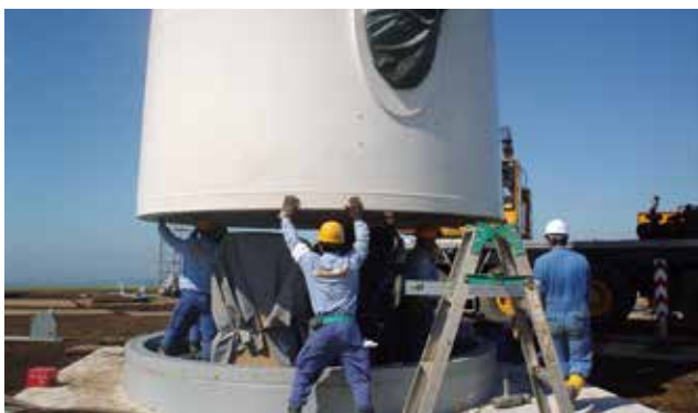
▲タワーの取り付け作業の様子
