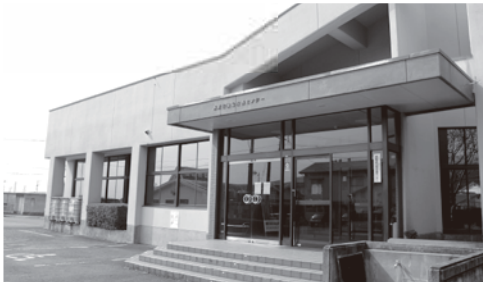
西原村構造改善センター建設
