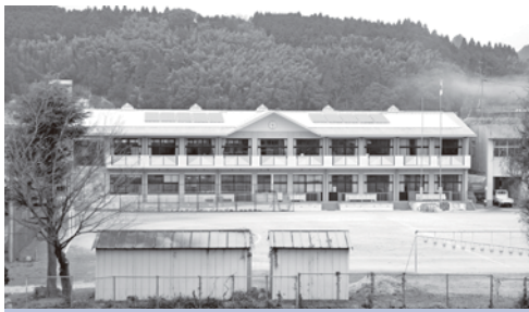
河原小学校校舎建設
