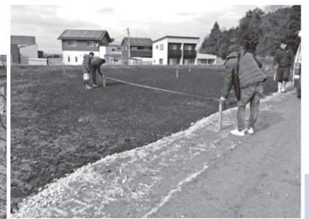
建設中の様子
