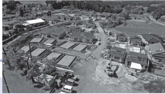
災害公営住宅(山西地区)〈7月末完成予定〉
