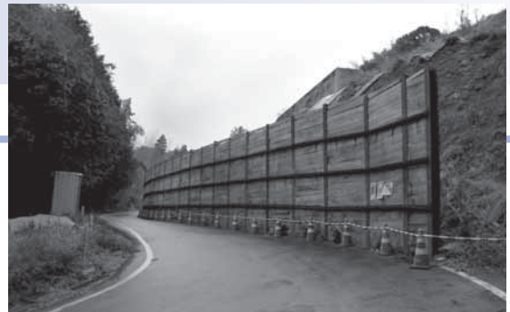
村道田中高遊線災害復旧工事
