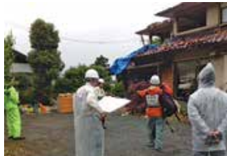
住家の被害認定調査
