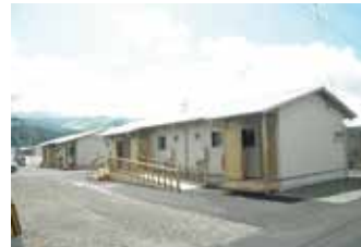
仮設住宅(木造)
