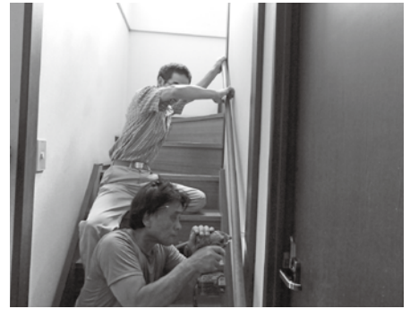
▲階段の手すり設置
