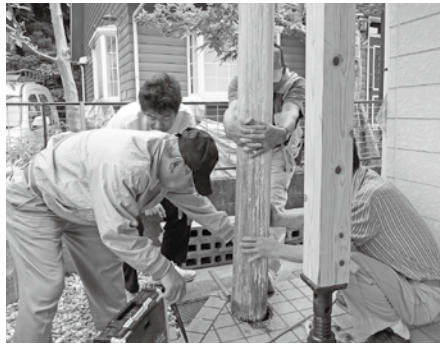
▲玄関の柱の交換と固定
