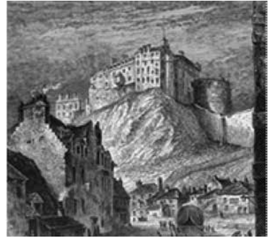
Edinburgh Castle, built around 1450 1450年頃に建てられたエディンバラ城
