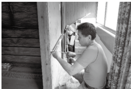
▲トイレ入口廊下の手すり設置
