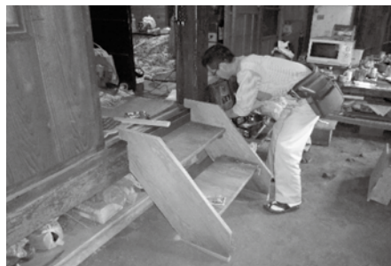
▲居間上り口階段設置
