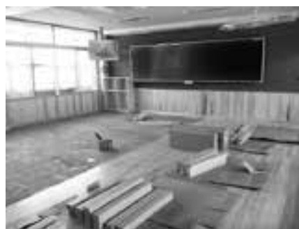
改修中の教室
