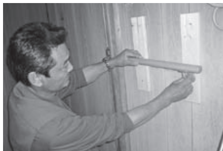
▲トイレ入口の手すり設置
