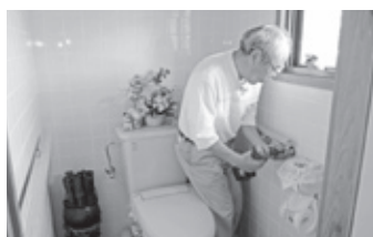
▲トイレの手すり設置
