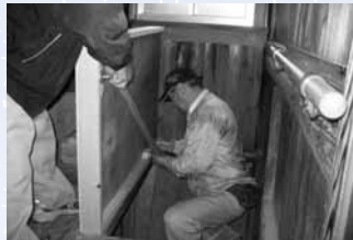
▲台所の壁と手すり
