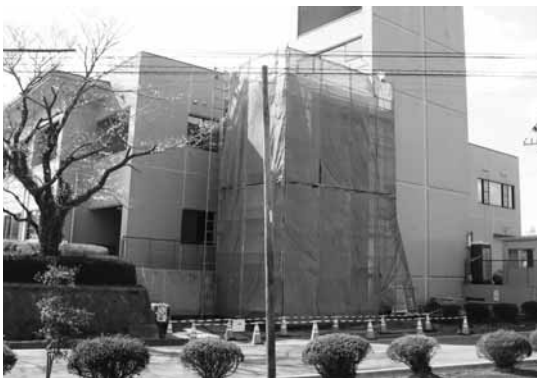
▲建設中のエレベーター
