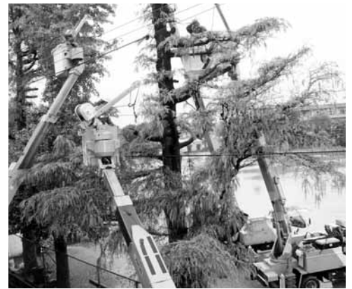
▲伐採作業の様子
