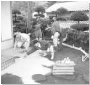
H18年度医王寺地区地域づくり 皆が集う公民館周りの危険箇所や舗装を住民で協力し合って整備。
