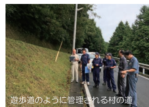
遊歩道のように管理される村の道
