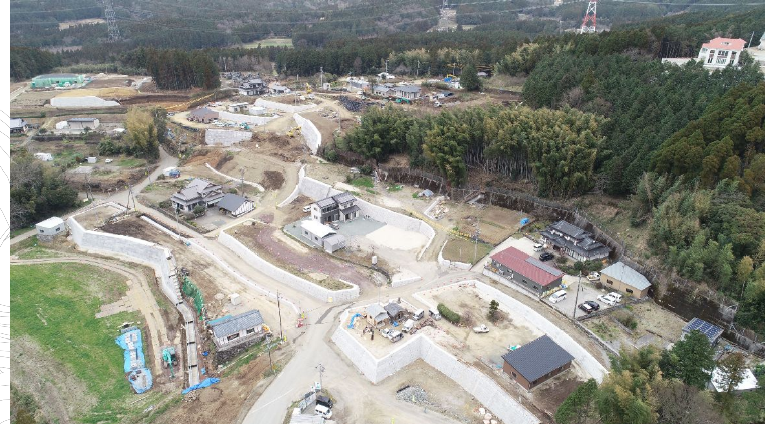
ドローン空撮【全景-1】 2020.2.25撮影
