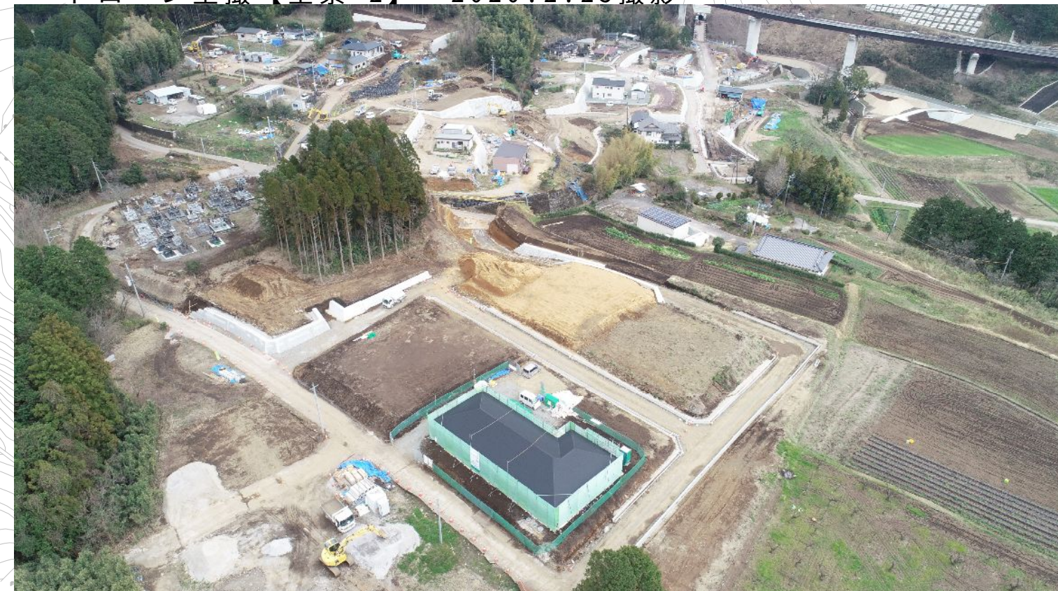
ドローン空撮【全景-2】 2020.2.25撮影
