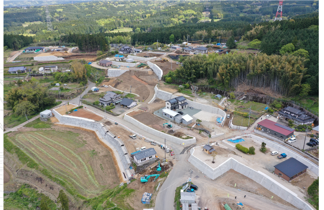
ドローン空撮【全景-1】 2020.4.24撮影
