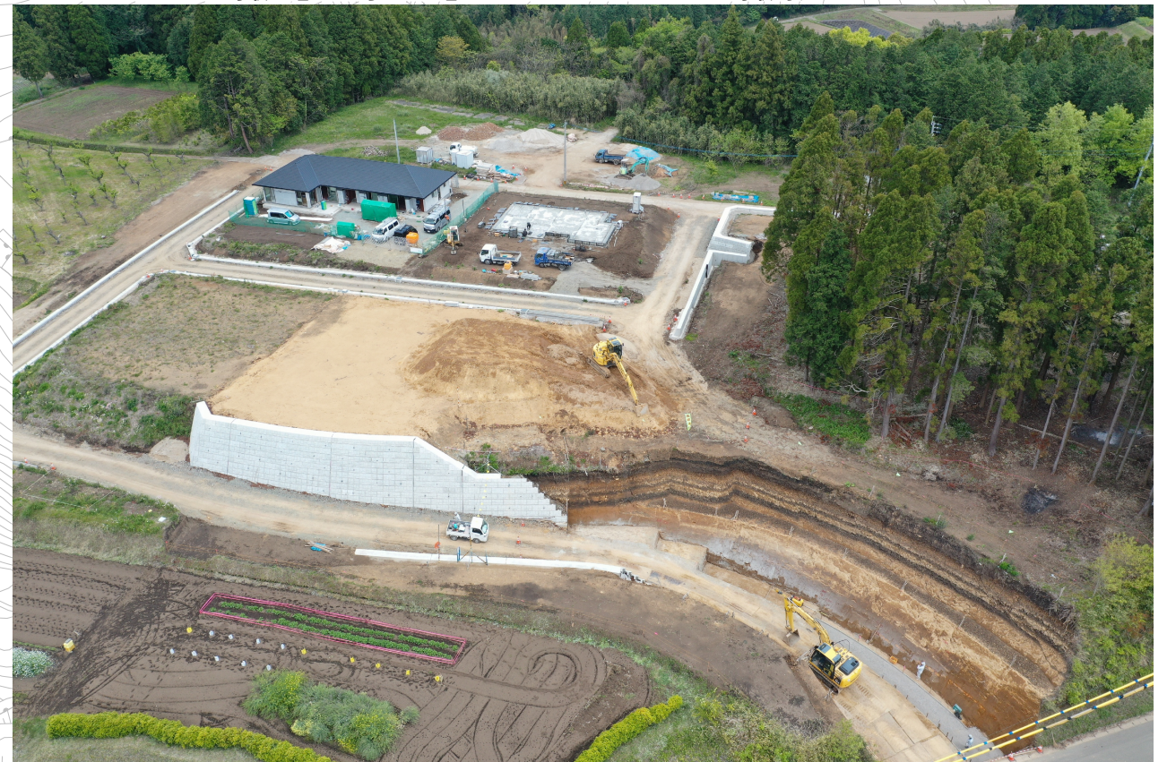
ドローン空撮【全景-2】 2020.4.24撮影
