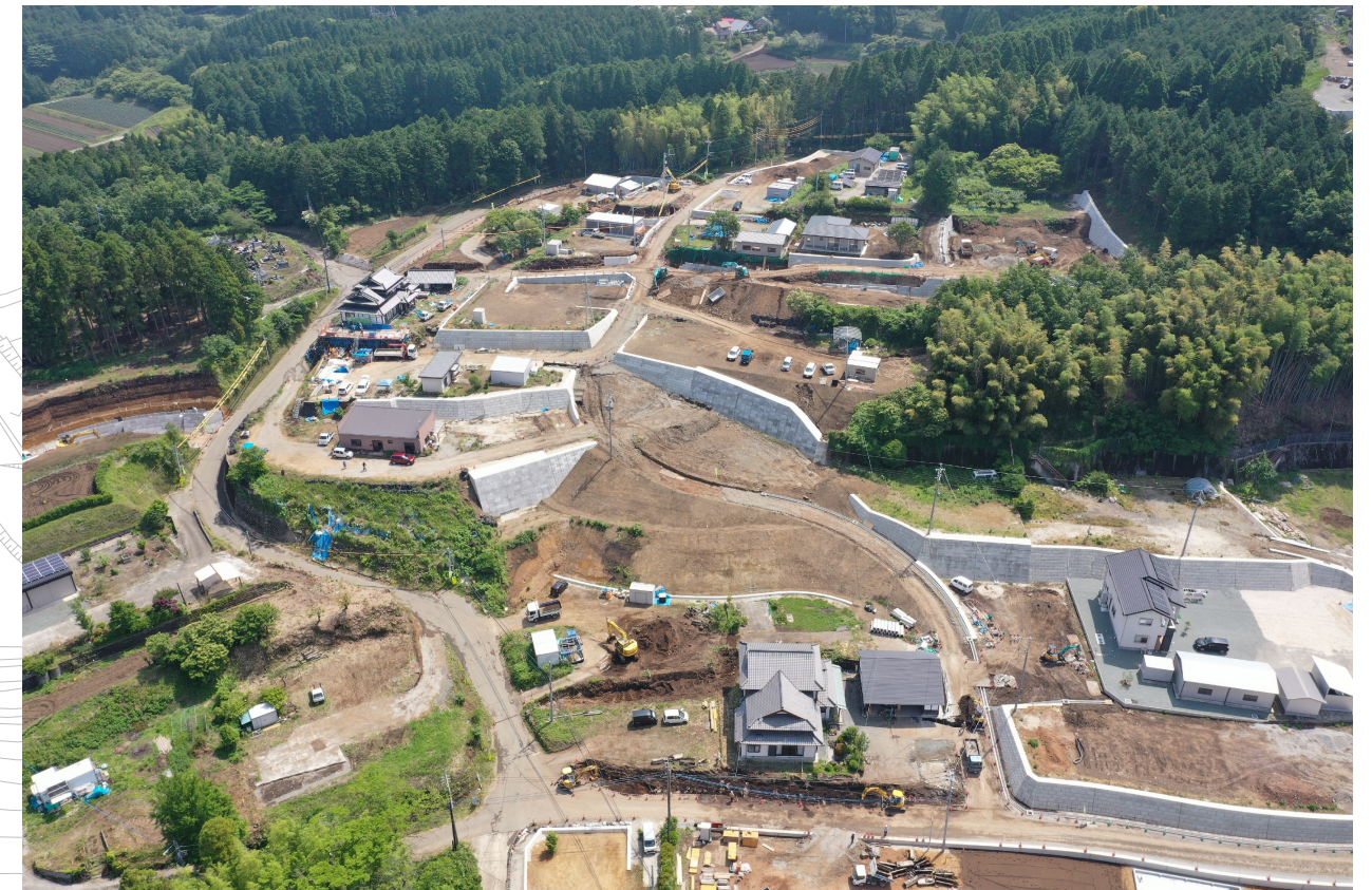
ドローン空撮【全景-1】 2020.5.26撮影
