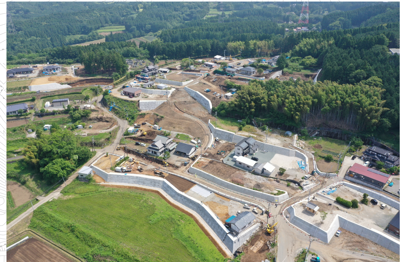
ドローン空撮【全景-2】 2020.5.26撮影
