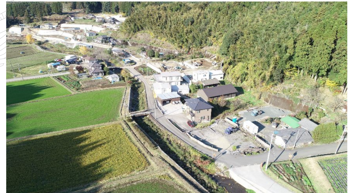
ドローン空撮【全景-東方】 2019.11.29撮影
