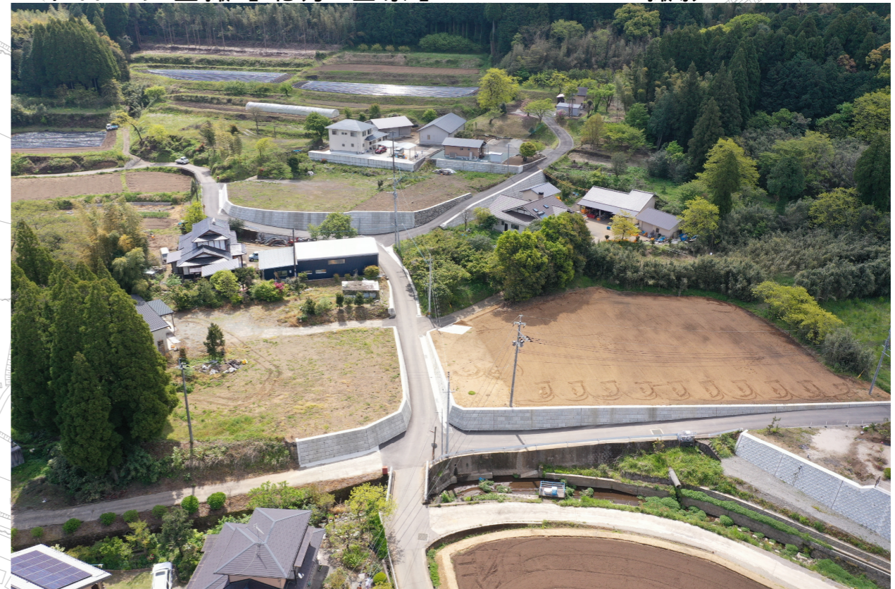
ドローン空撮【北方-全景】 2020.4.24撮影
