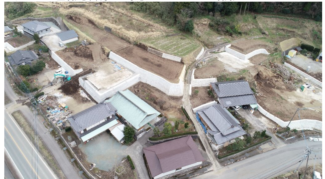
ドローン空撮【西方-全景】 2020.2.25撮影
