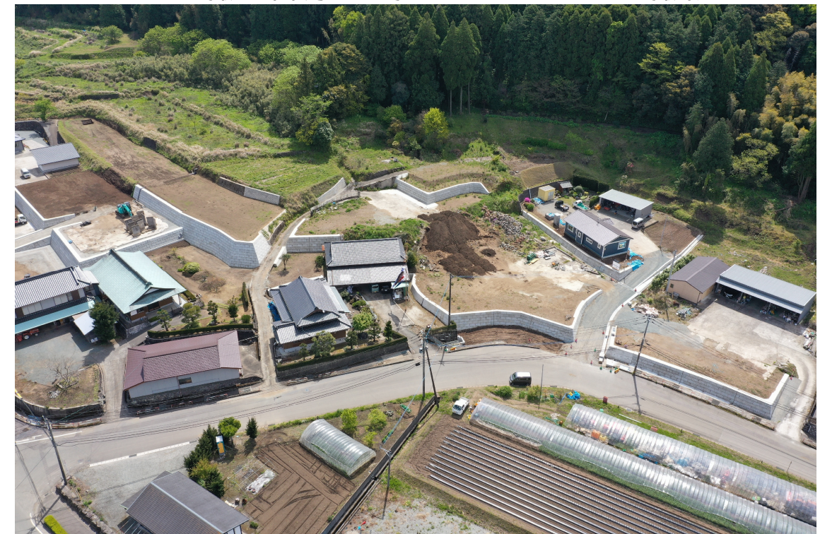
ドローン空撮【西方-全景】 2020.4.24撮影
