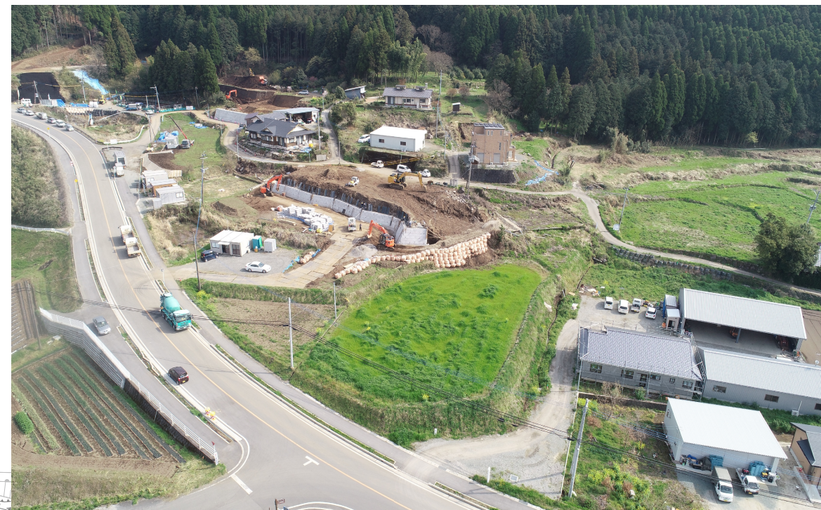
ドローン空撮【全景-2】 2019.04.02撮影
