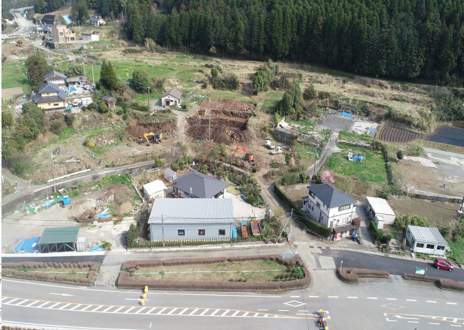
ドローン空撮【全景-1】 2019.04.02撮影
