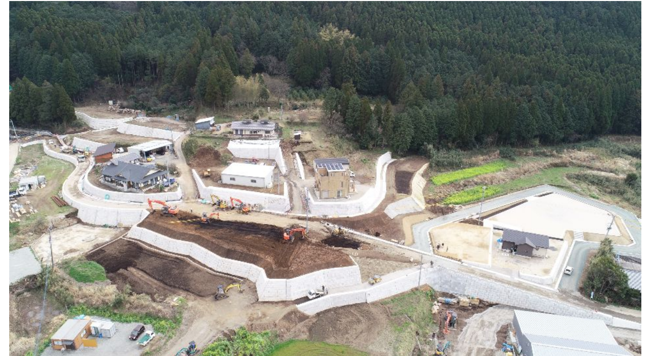
ドローン空撮【東方-全景】 2020.2.25撮影
