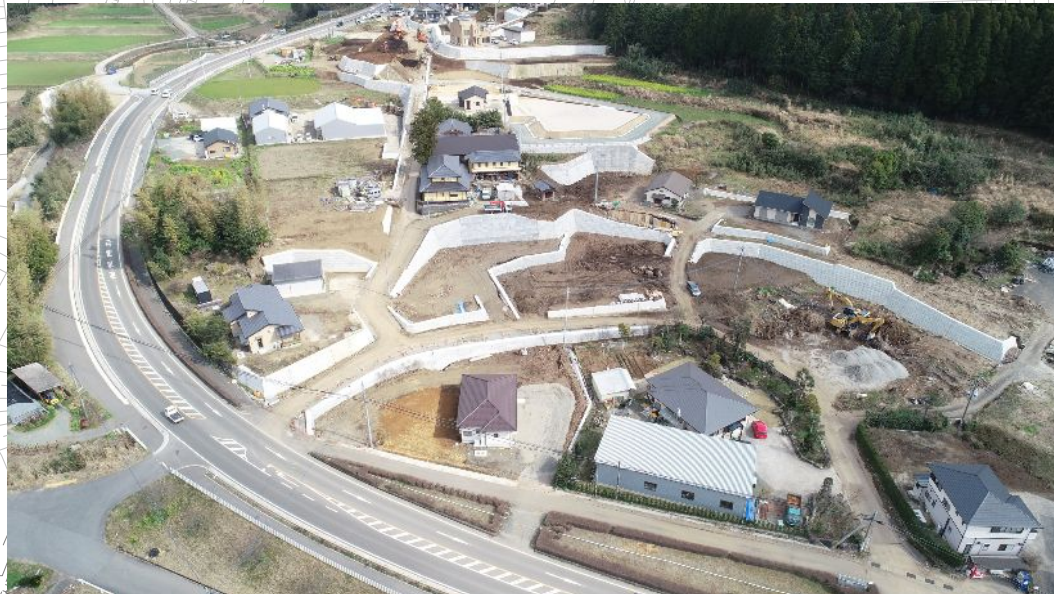
ドローン空撮【中央-全景】 2020.2.25撮影
