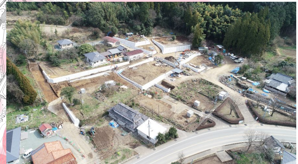
ドローン空撮【上布田-全景】 2020.2.25撮影
