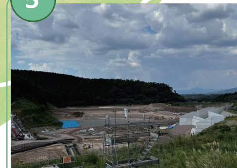
2024年10月1日 大切畑ダムの工事景
