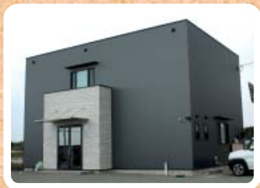
商工会館《全景》
