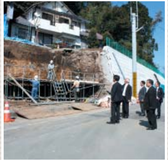
公共土木施設 災害復旧工事(星田)
