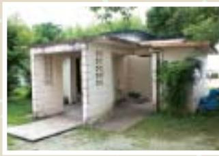
古くて危険な山西小屋外トイレ
