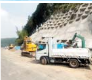
県道熊本高森線の工事
