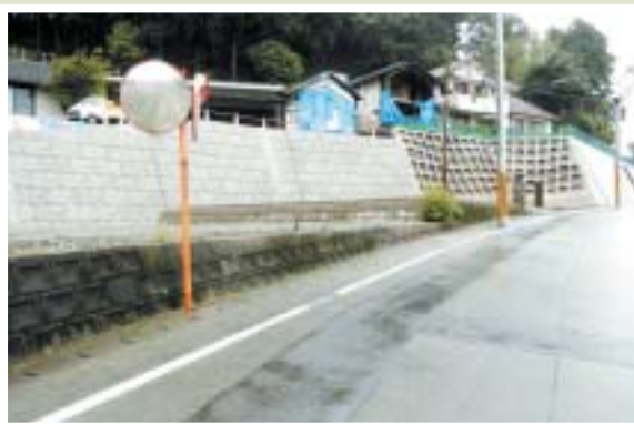
完了した星田地区防災がけ崩れ対策事業
