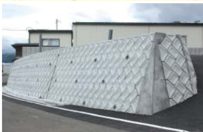
復旧が終わった擁壁
