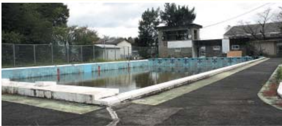
山西小学校プール
